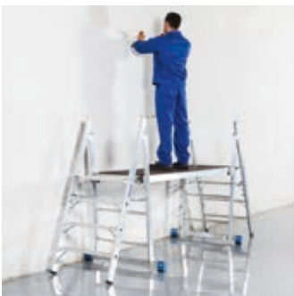
2 profi fellépő és 1 palló segítségével nagy munkafelület alakítható ki
